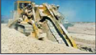
KANAL KAZI VE KABLO SERME ESNASINDA
